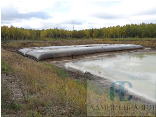
Рис. 7. Заполненный Геотуб®. Высота 2,4 м
