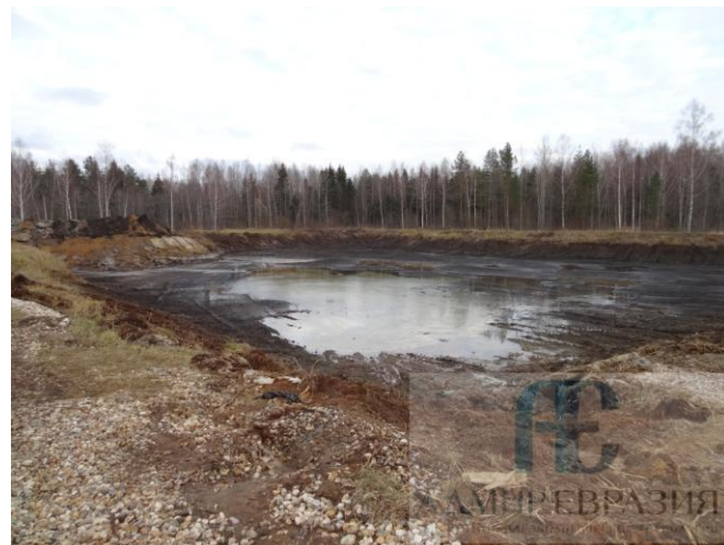
Рис. 8. Шламонакопитель после расчистки
