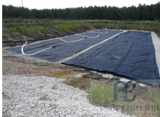
Рис. 6. Подготовленная к работе площадка
