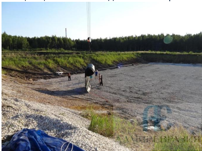
Рис. 5. Монтаж Геотуб®
